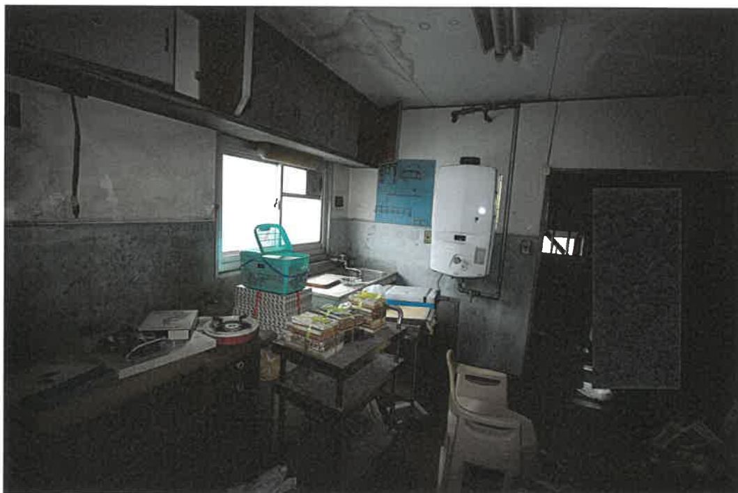
物件 2 建物 3 階室内
