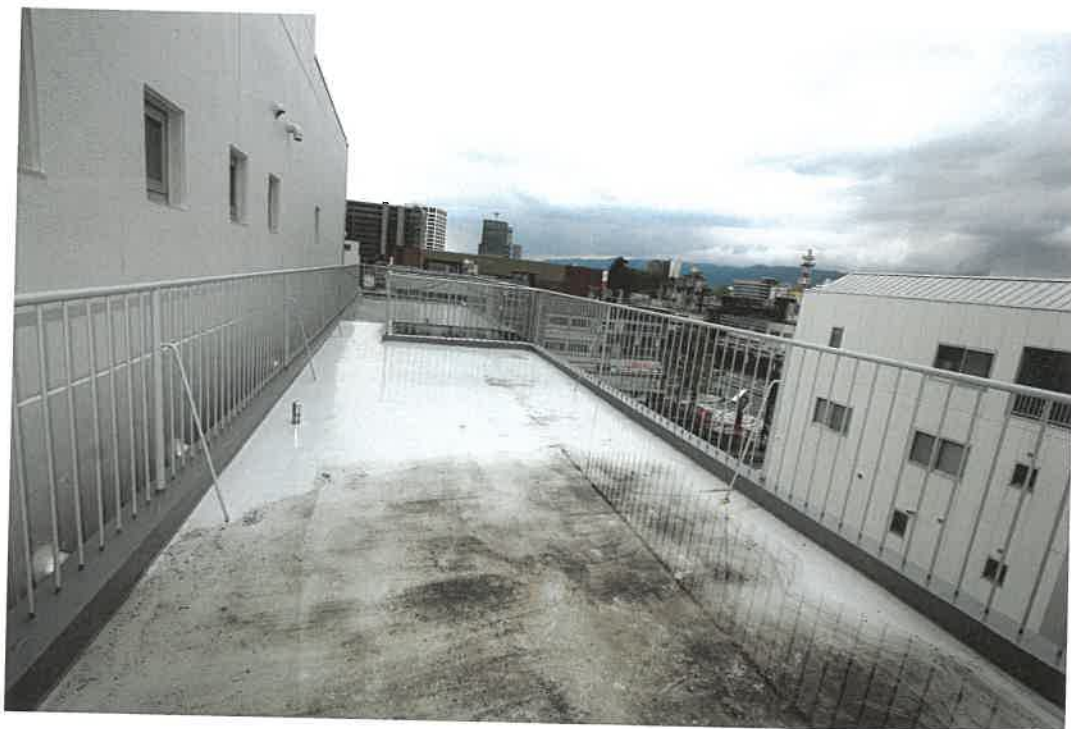
物件 2 建物 屋上
