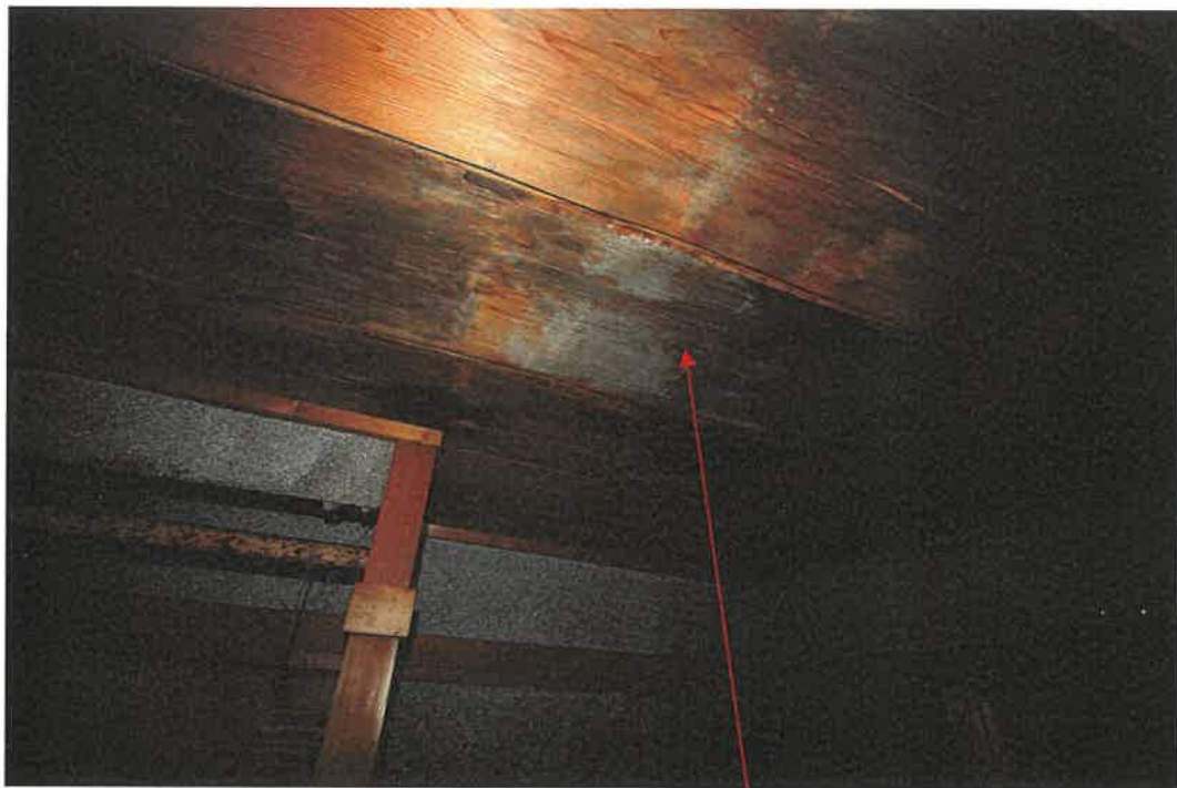
物件 2 建物 2 階室内
