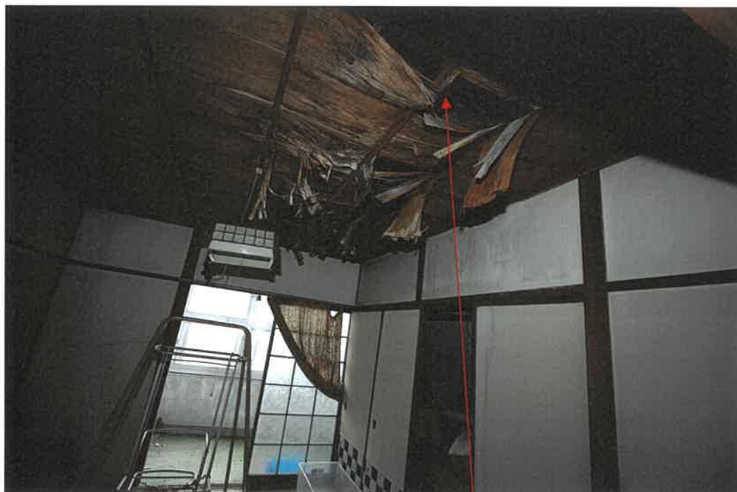
物件 2 建物 4 階室内
