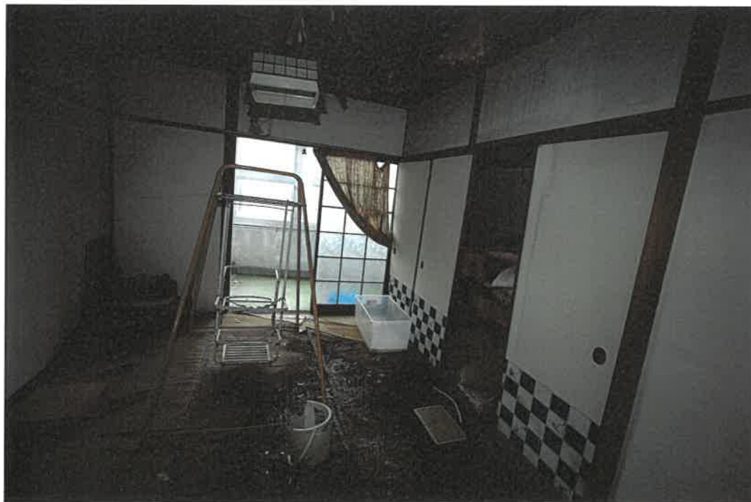
物件 2 建物 4 階室内
