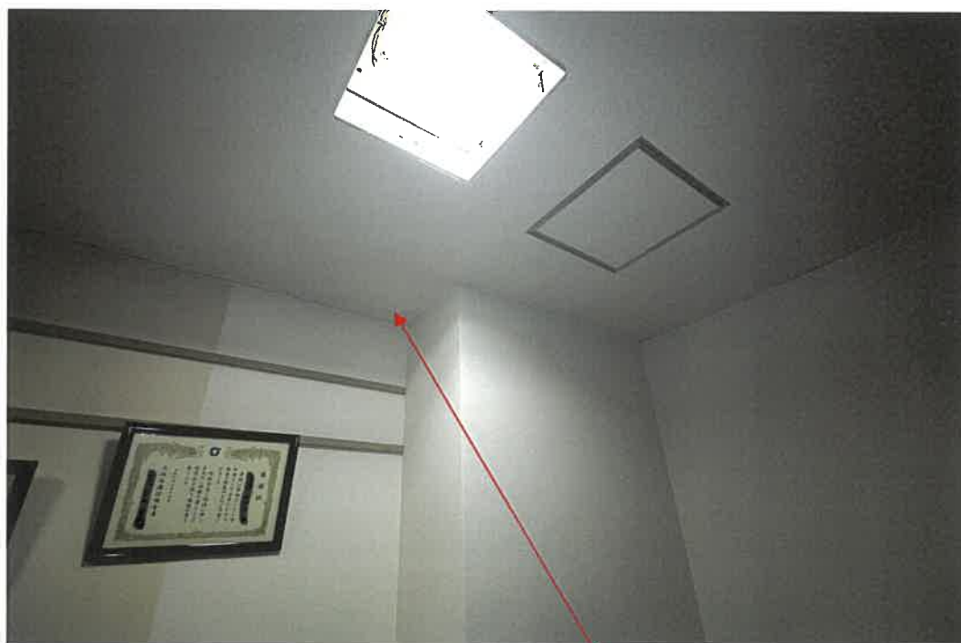
物件 2 建物 1 階室内
