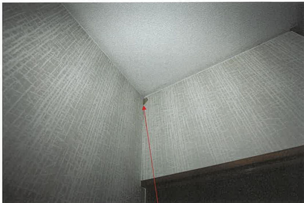
物件 8 建物 1 階室内
