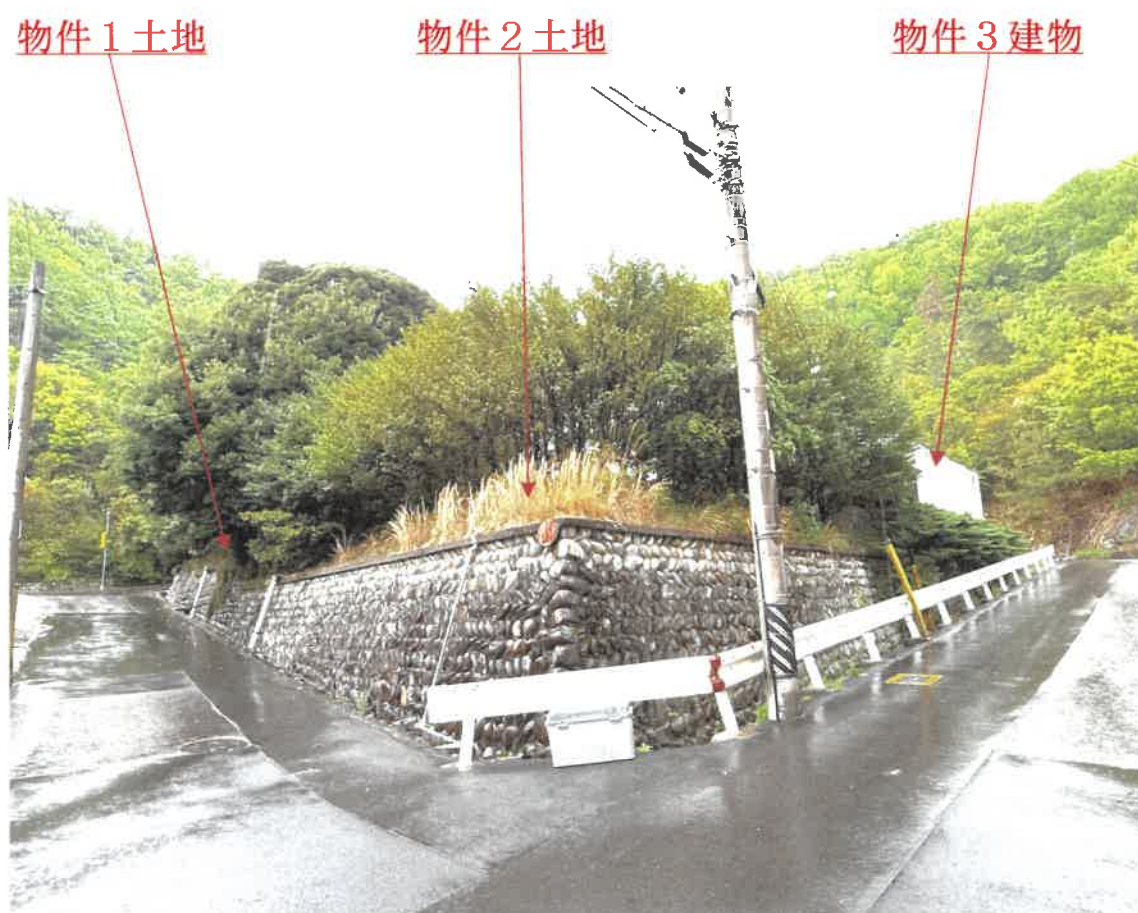
目的物件の現況写真
