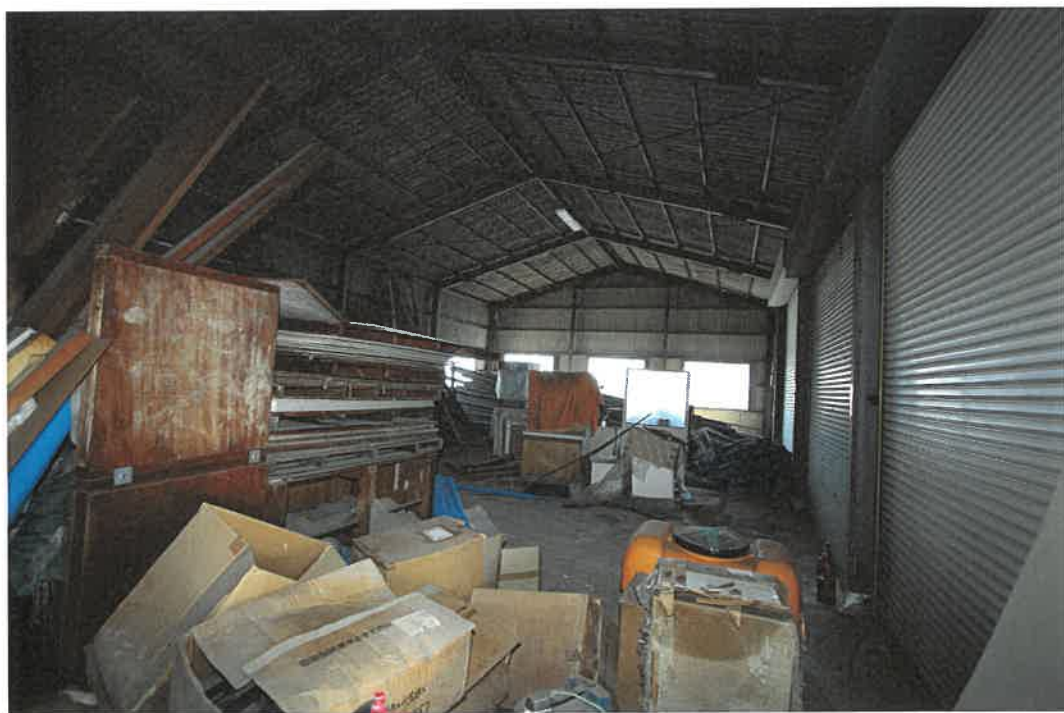
物件 3 附属建物 1 室内
