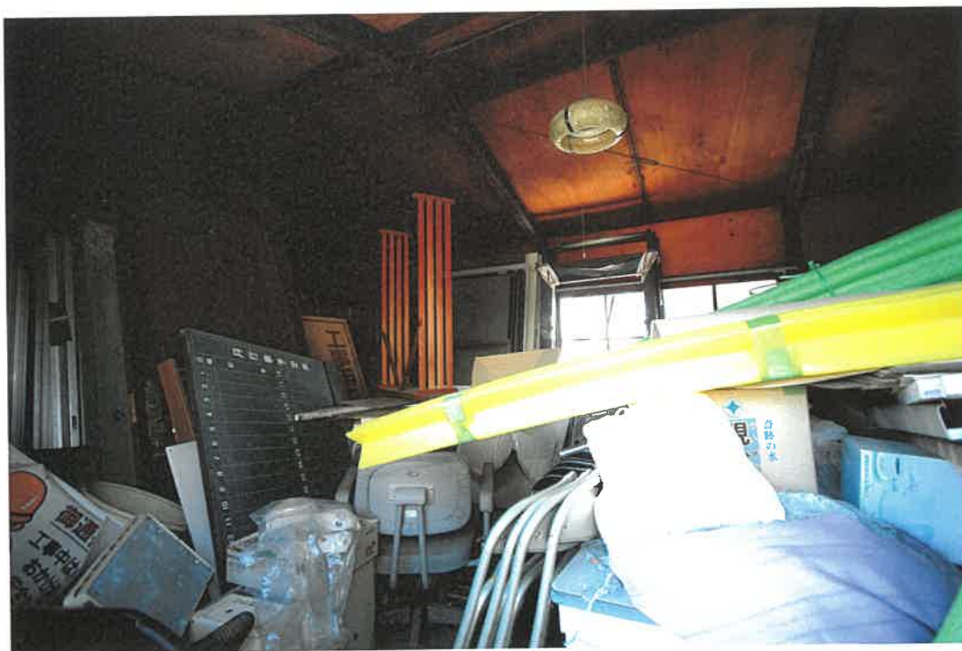
物件 3 附属建物 5 室内
