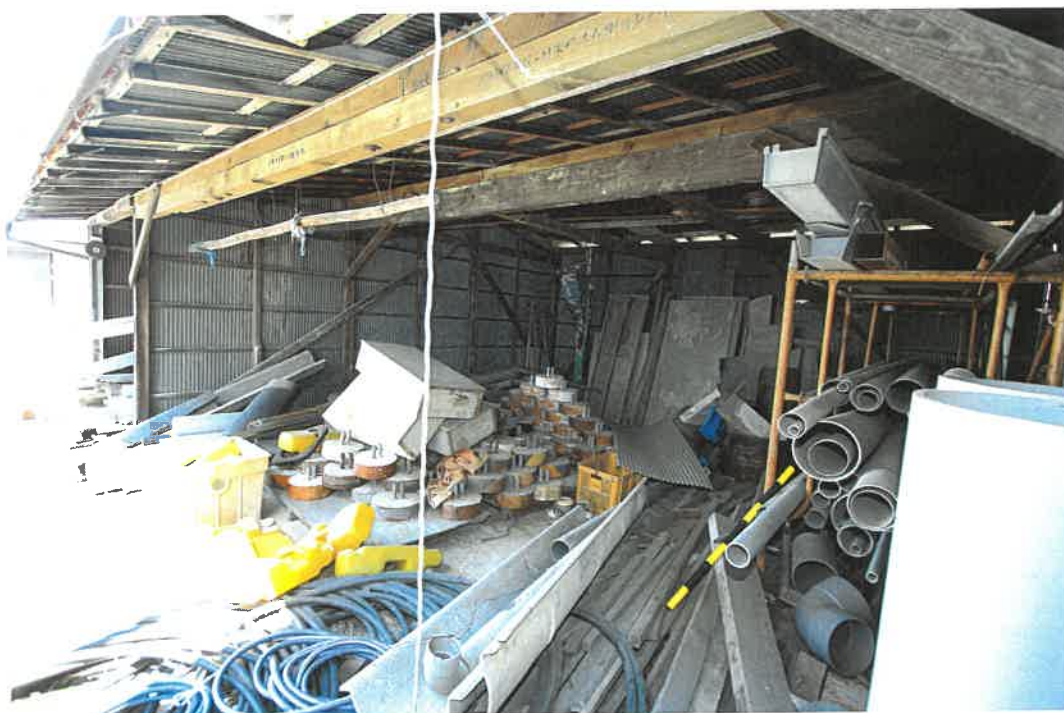
物件 3 附属建物 2 室内
