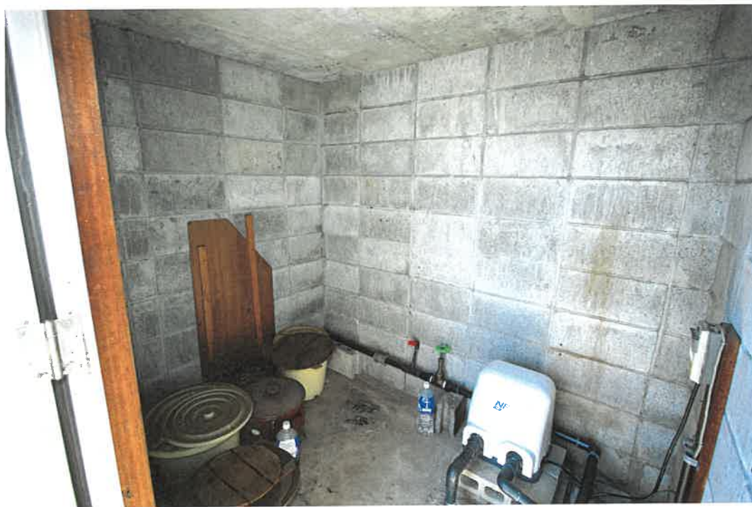
物件 3 附属建物 3 室内
