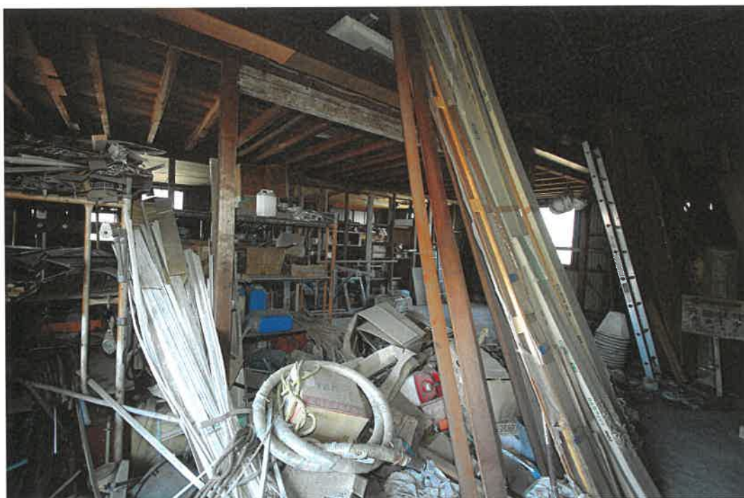
物件 3 附属建物 1 室内
