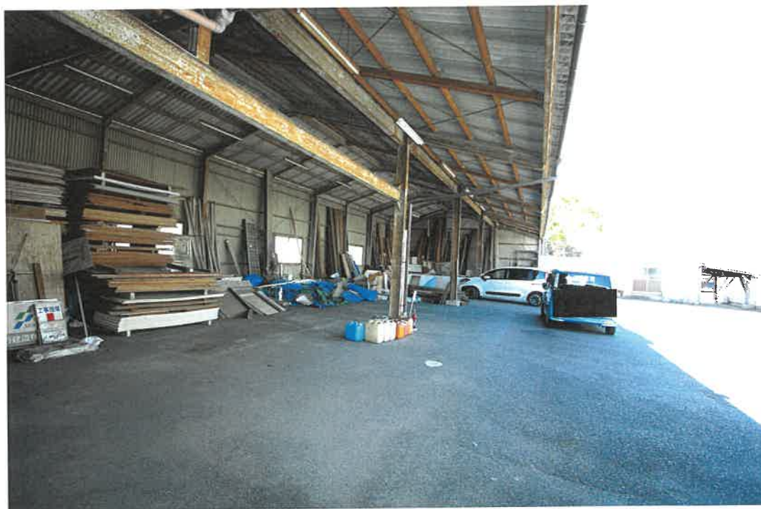
物件 3 附属建物 1 室内
