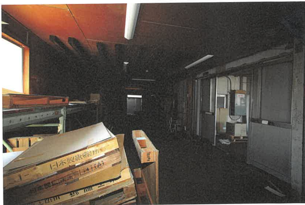
物件 5 附属建物 1 1 階室内
