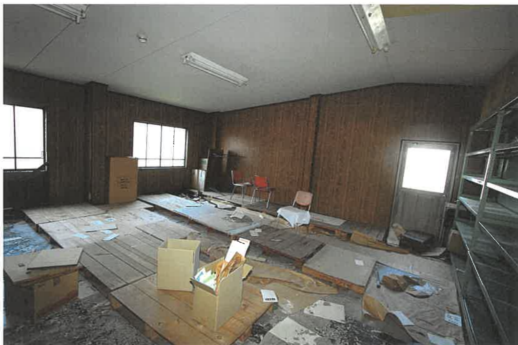
物件 4 建物 2 階室内
