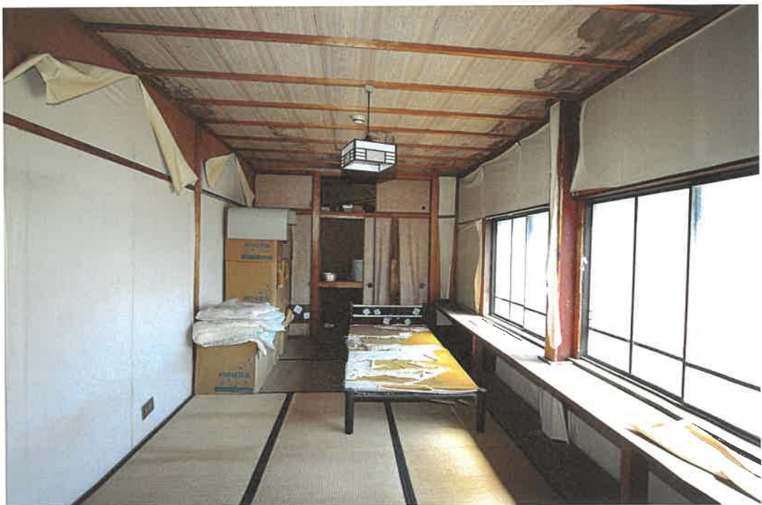
物件 4 建物 2 階室内
