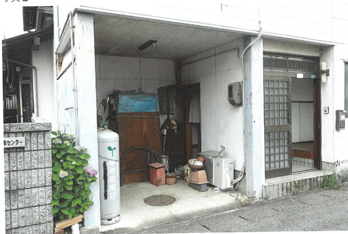
物件2建物の車庫部分
