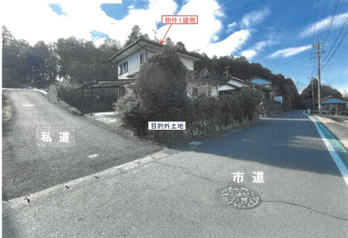
写真② 接道市道より撮影
