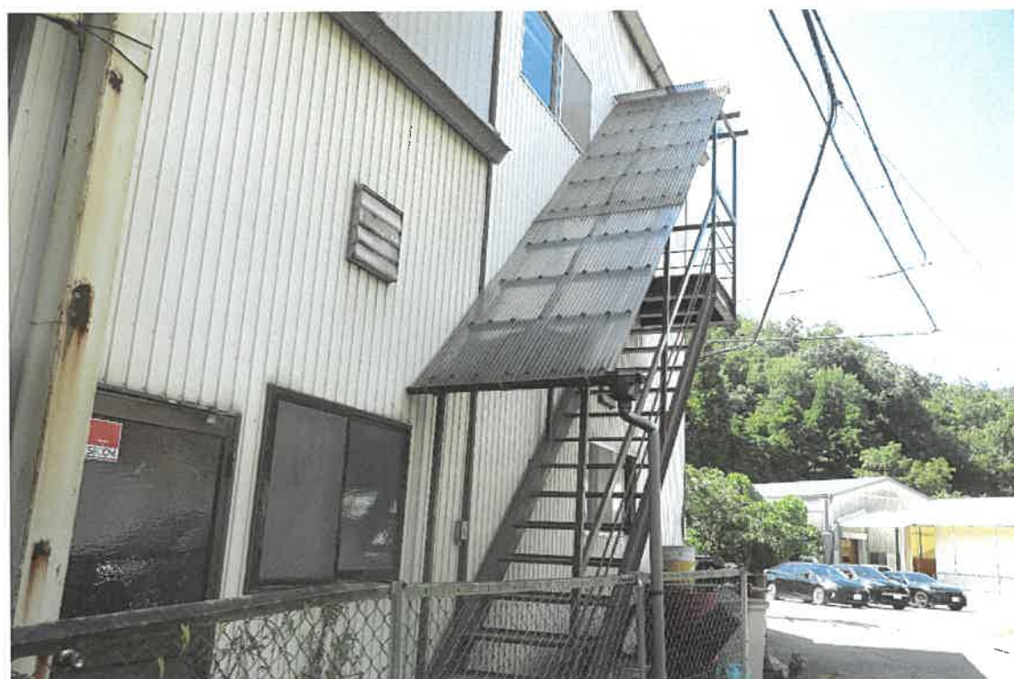
物件 4 建物北側の 2 階へ出入りする外付階段
