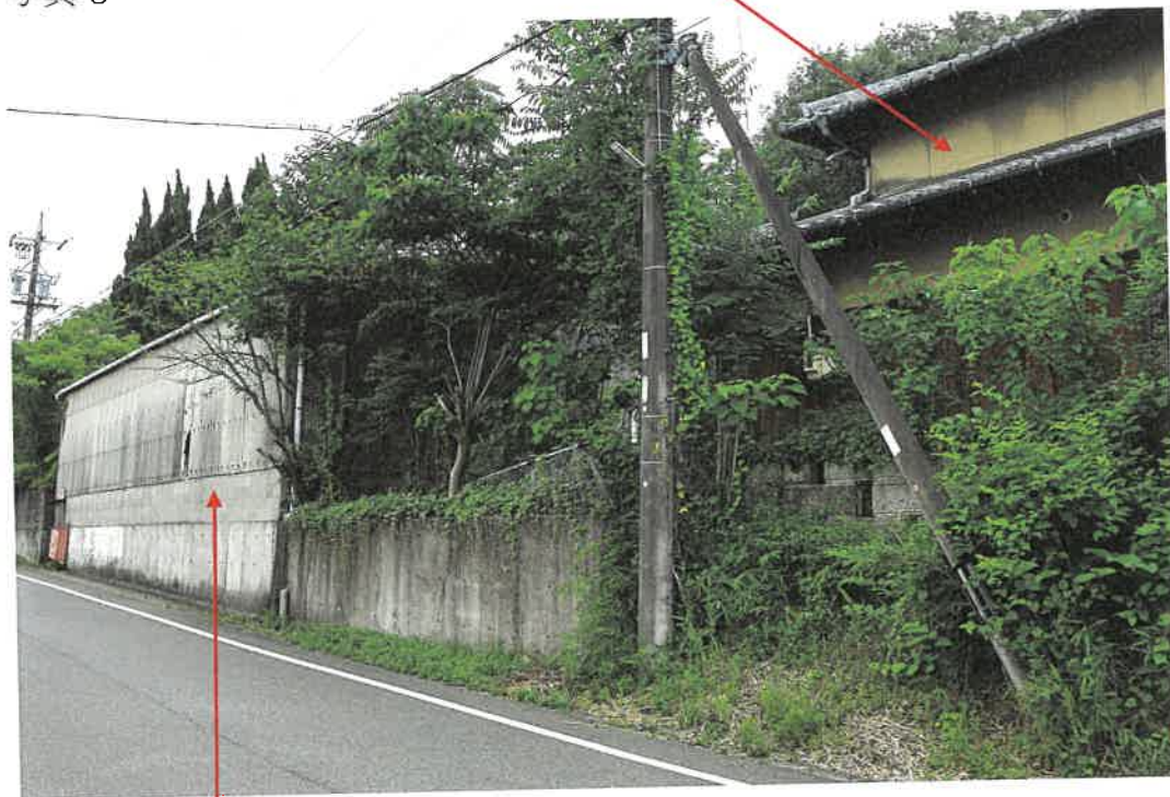
物件 4 附属建物
