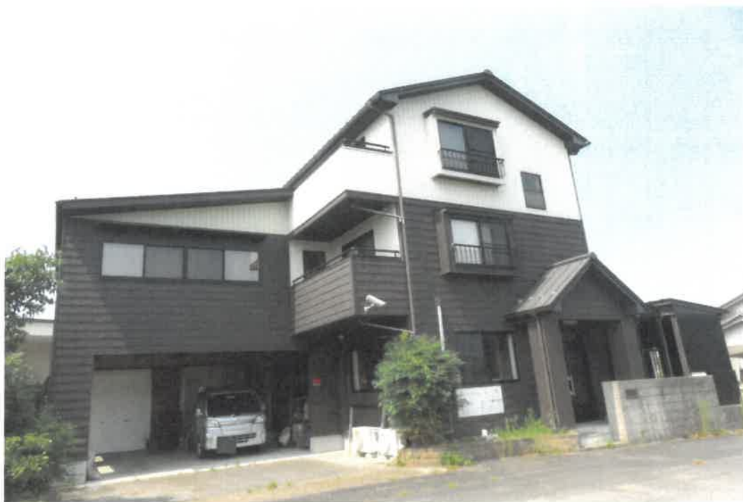
物件建物の北東方から撮影
