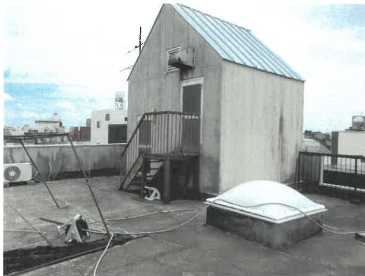
物件 2 建物の屋上 塔屋兼物置を撮影
