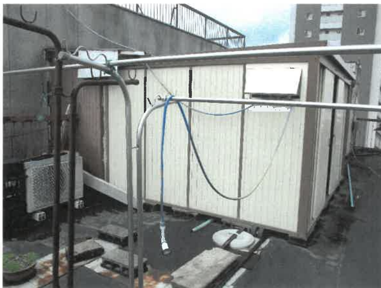
物件 4 建物の屋上 仮設の物置を撮影
