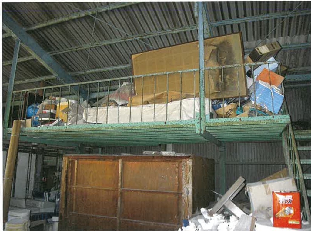
前同建物の倉庫内
