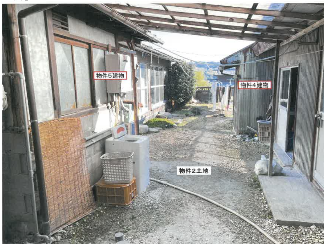
写真⑥ 物件2土地内より撮影
