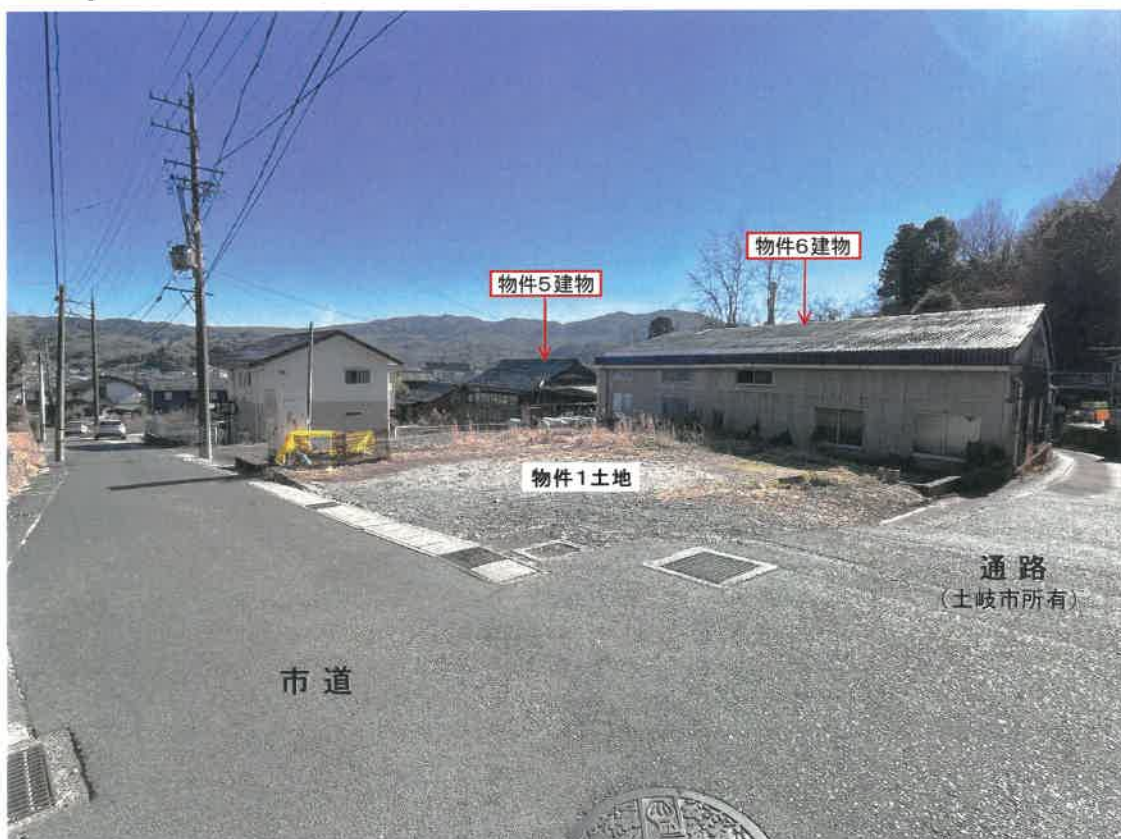
写真② 北側市道より撮影
