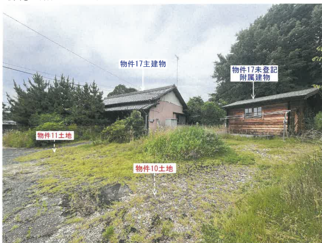
写真③ 物件土地内より撮影
