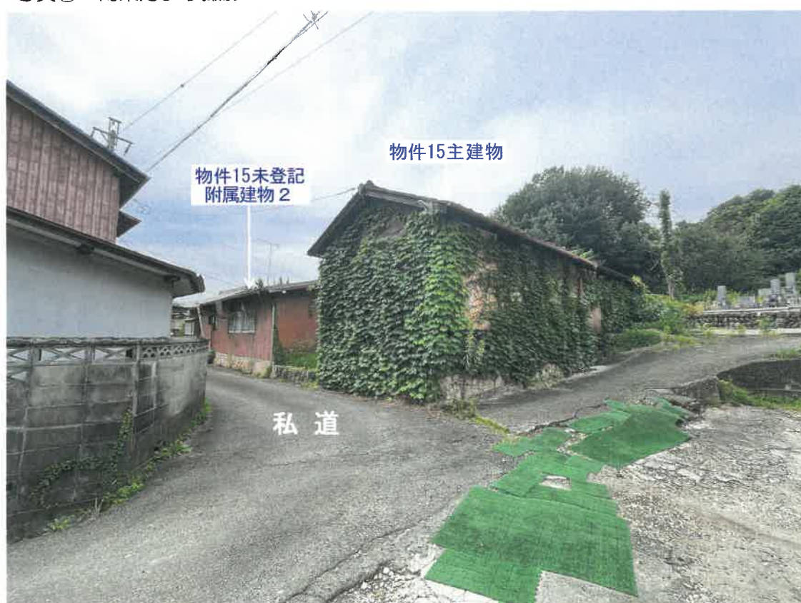
写真⑥ 南東方より撮影
