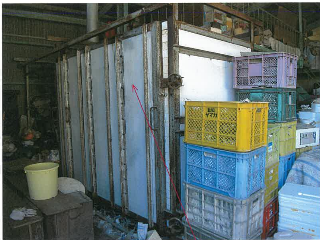
前同建物の倉庫内（陶磁器窯（素焼き窯））
