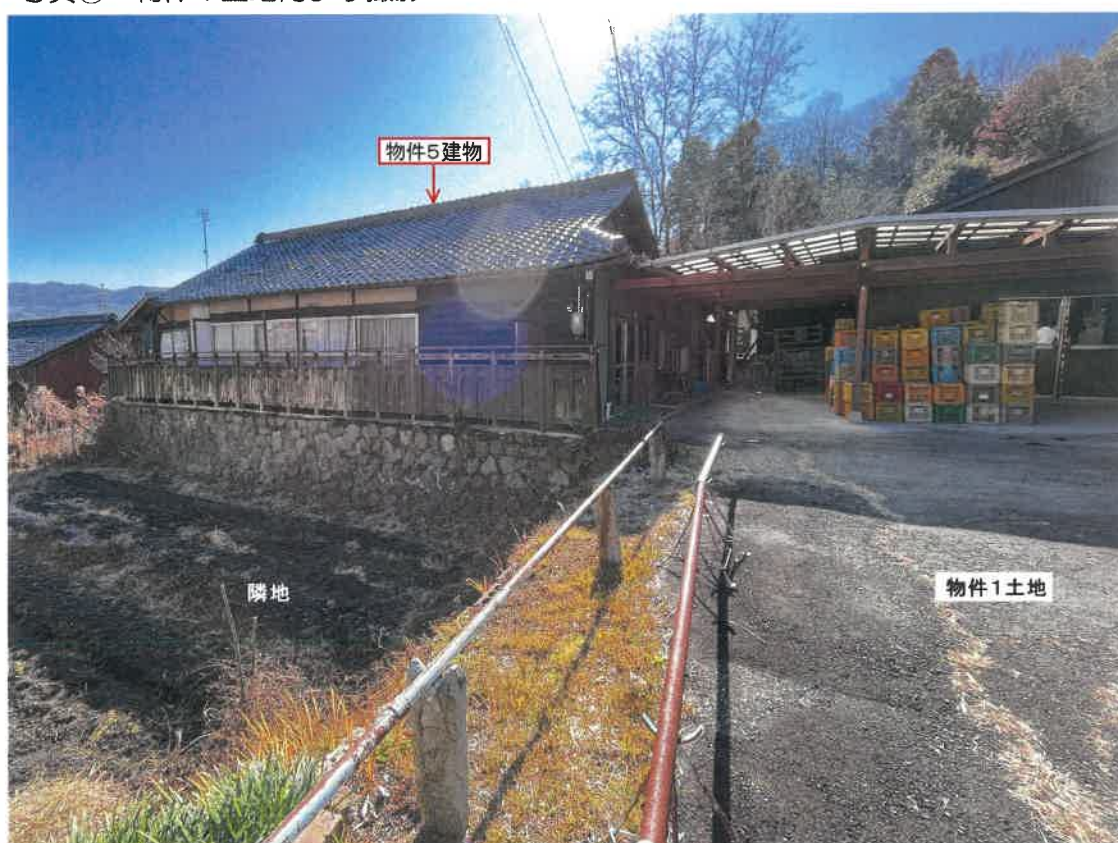
写真④ 物件1土地内より撮影
