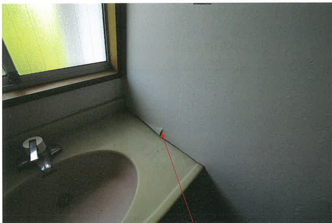
物件 2 建物 2 階室内
