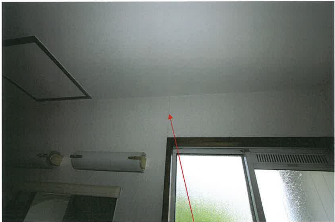
物件 2 建物 2 階室内
