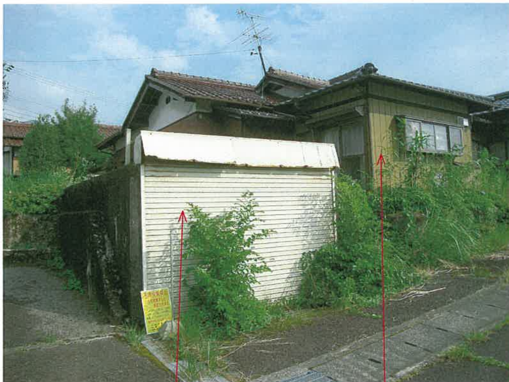
物件 3 未登記附属建物ア
