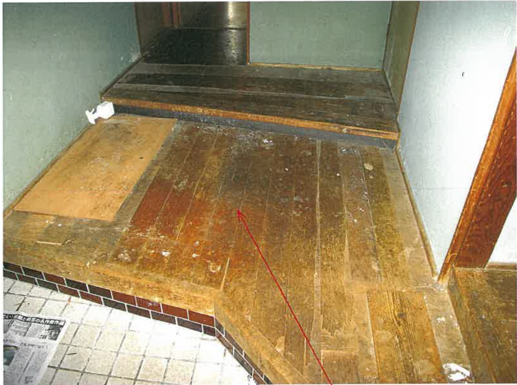
前同建物の玄関ホール（不安定箇所）
