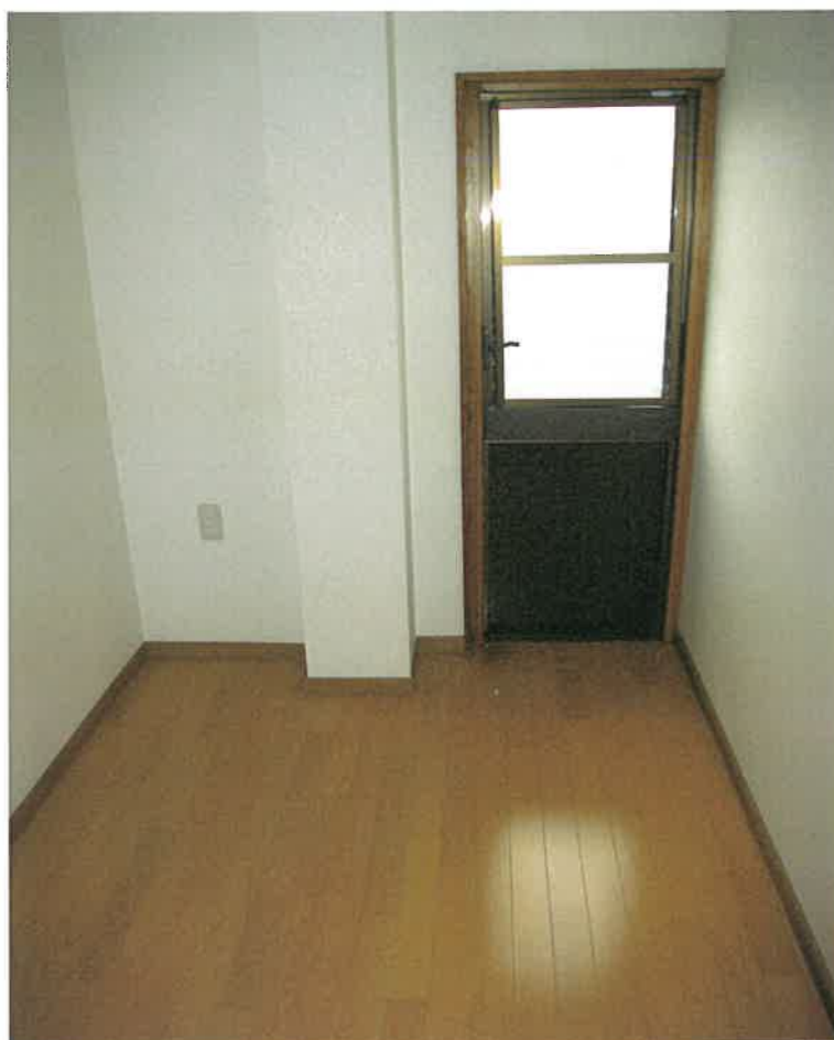
前同建物の2階室内
