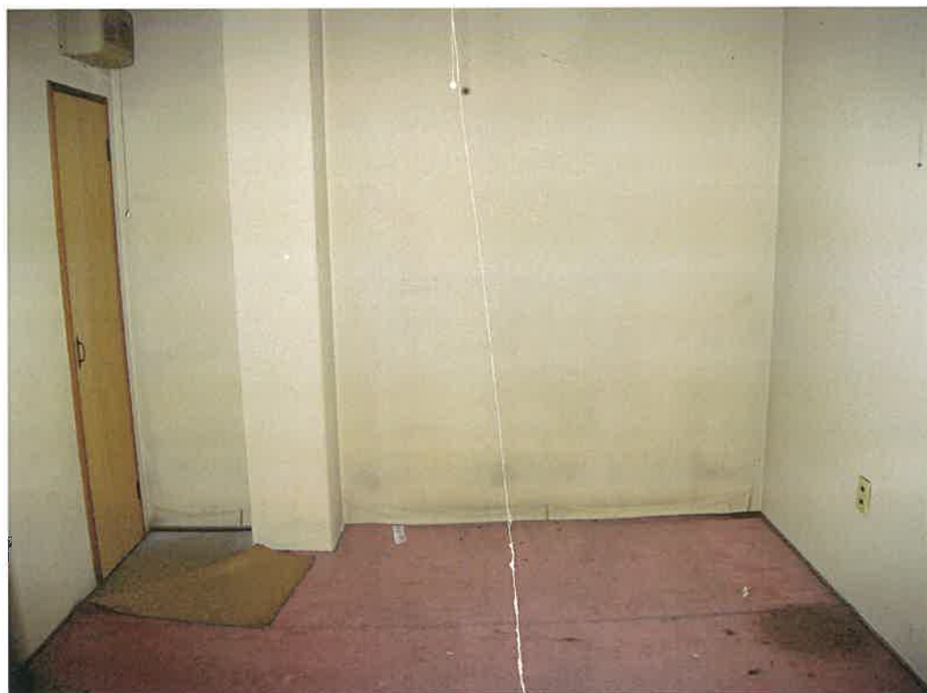
前同建物の1階物置内
