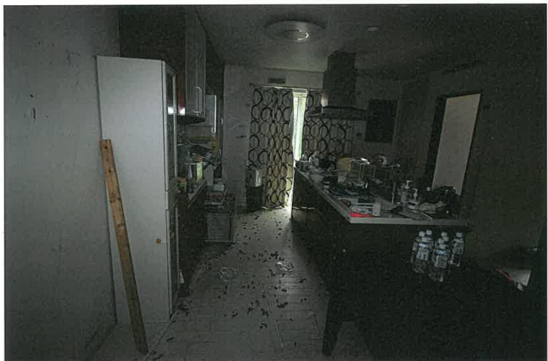
物件 2 建物 1 階室内
