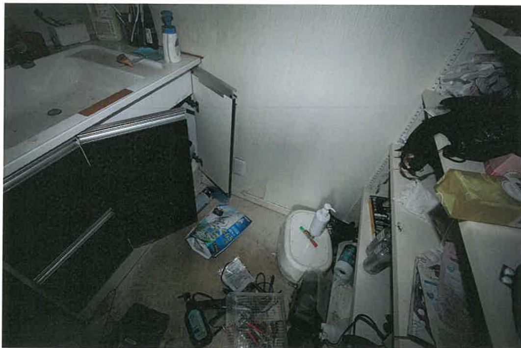
物件 2 建物 1 階室内
