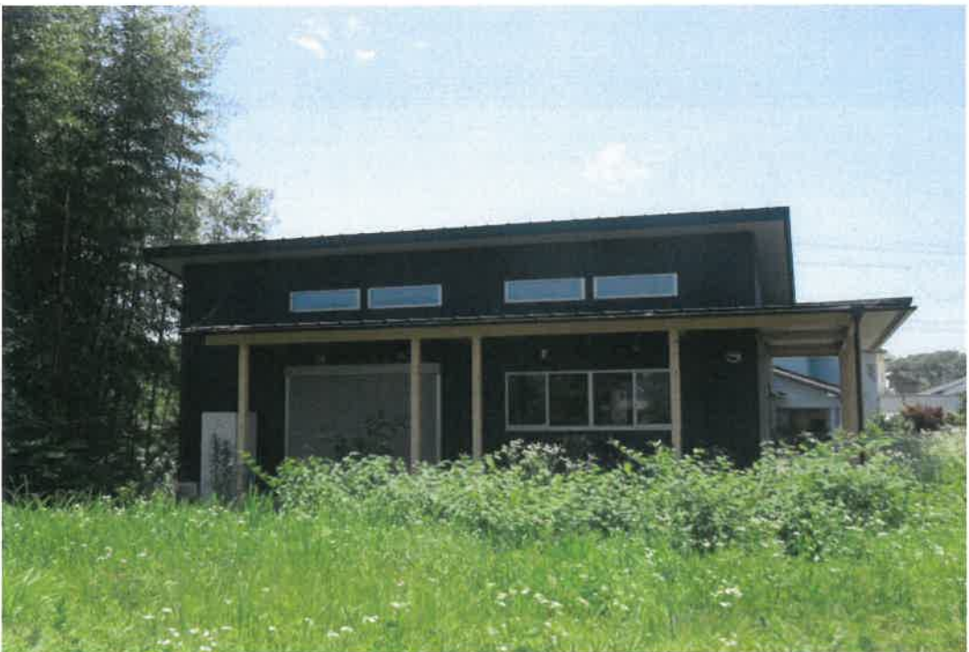
物件建物の東方から撮影
