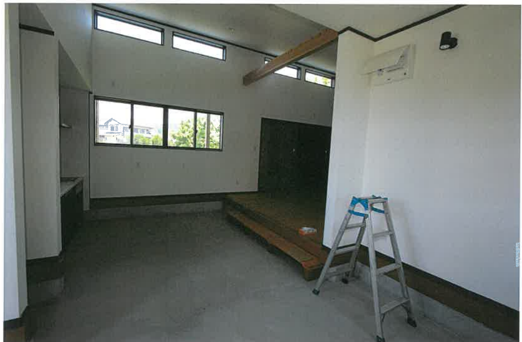
物件 5 建物 室内
