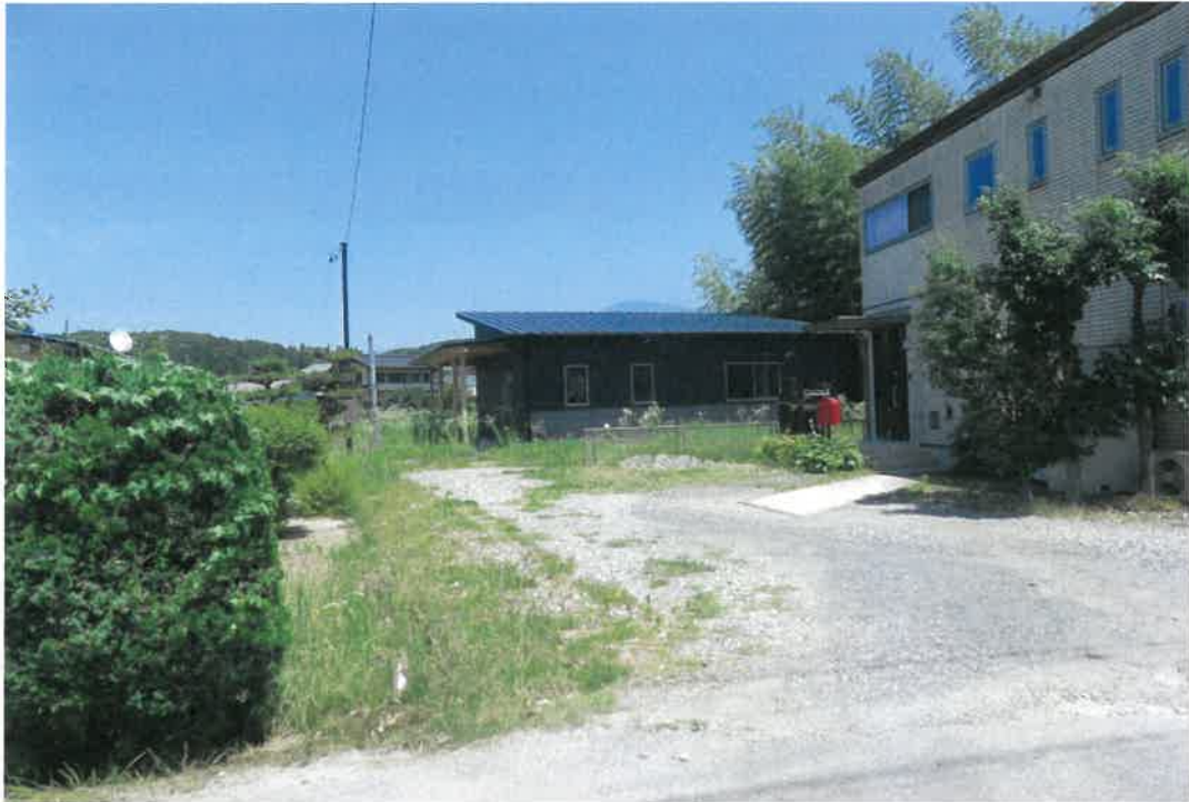
物件建物の北西方から撮影
