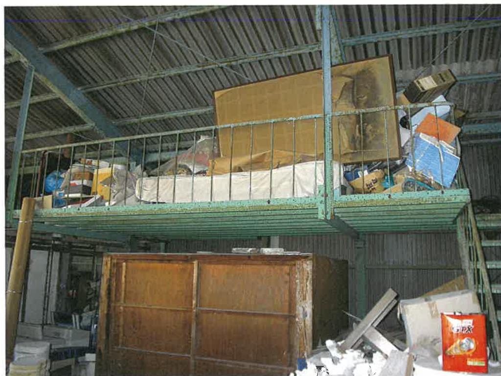
前同建物の倉庫内
