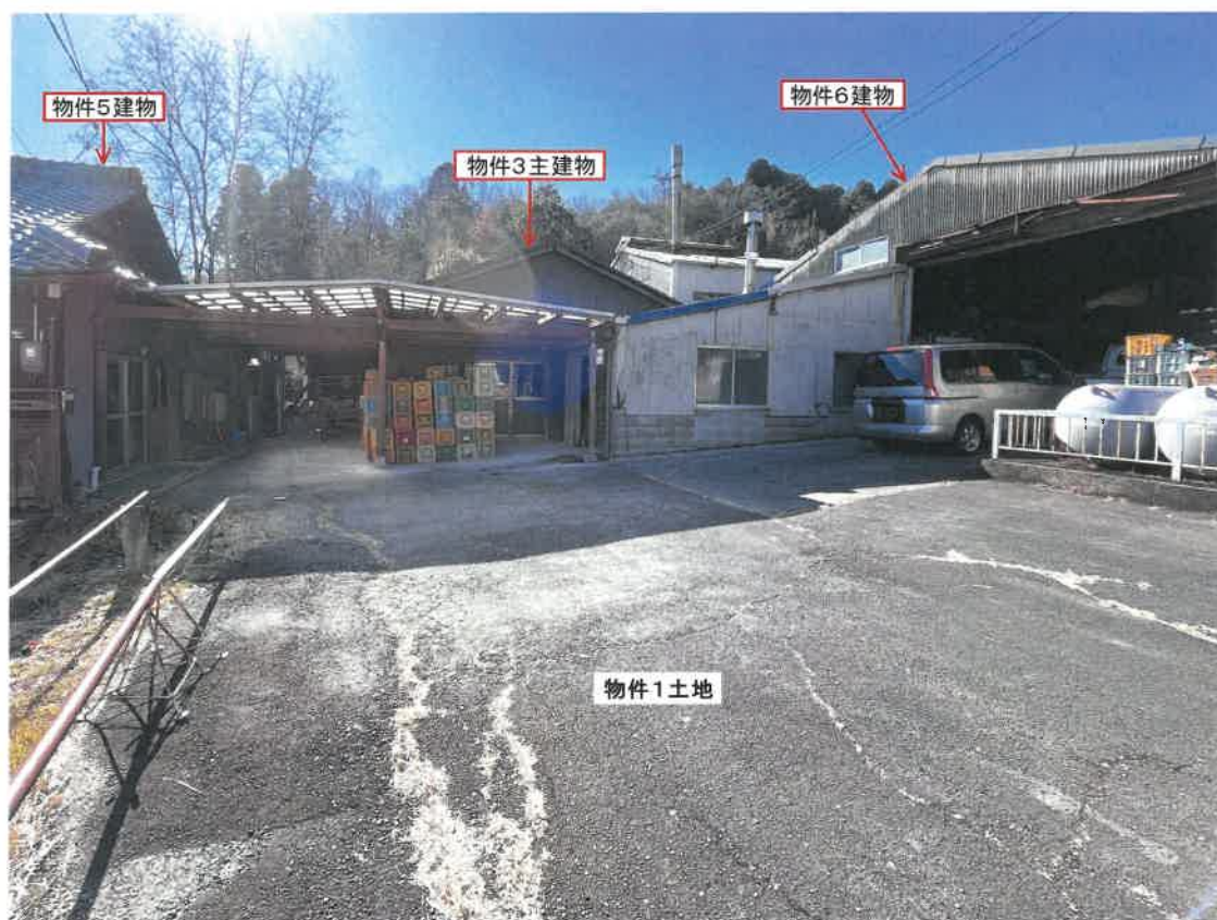
写真③ 物件1土地内より撮影
