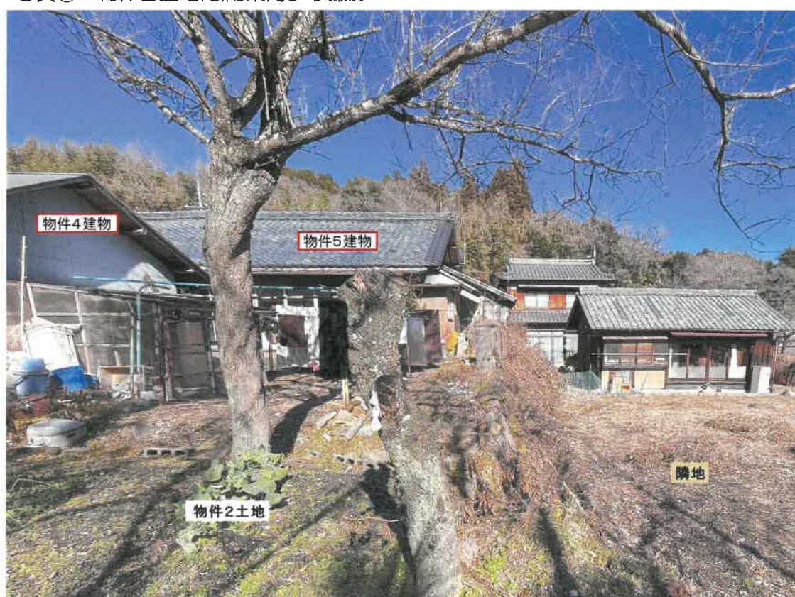
写真⑧ 物件2土地内,南東角より撮影
