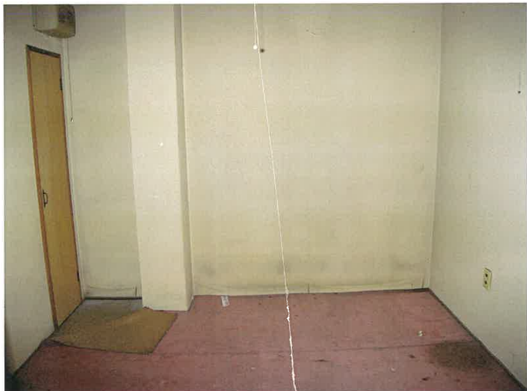
前同建物の1階物置内
