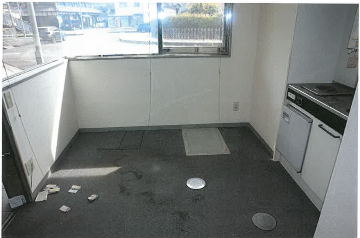
物件 2 建物 1 階管理室
