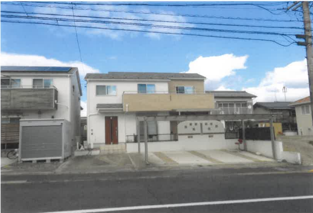
物件土地建物の南方から撮影
