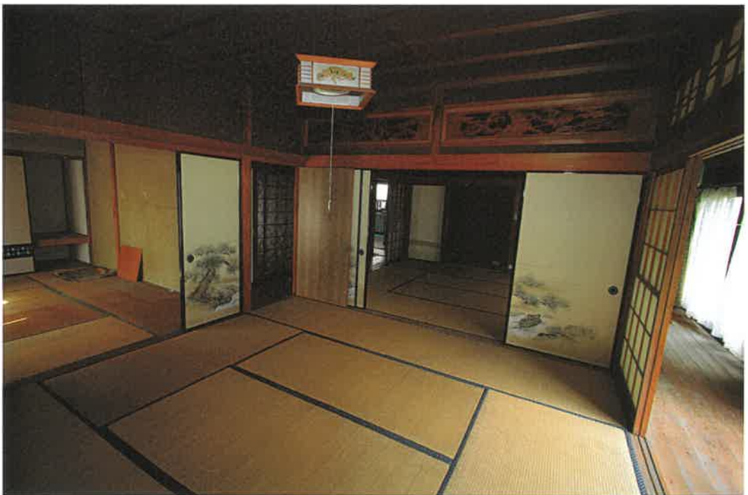
物件 3 建物 室内
