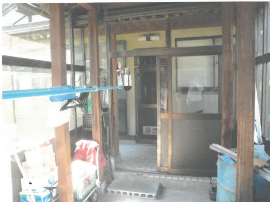
物件3建物の内部を撮影
