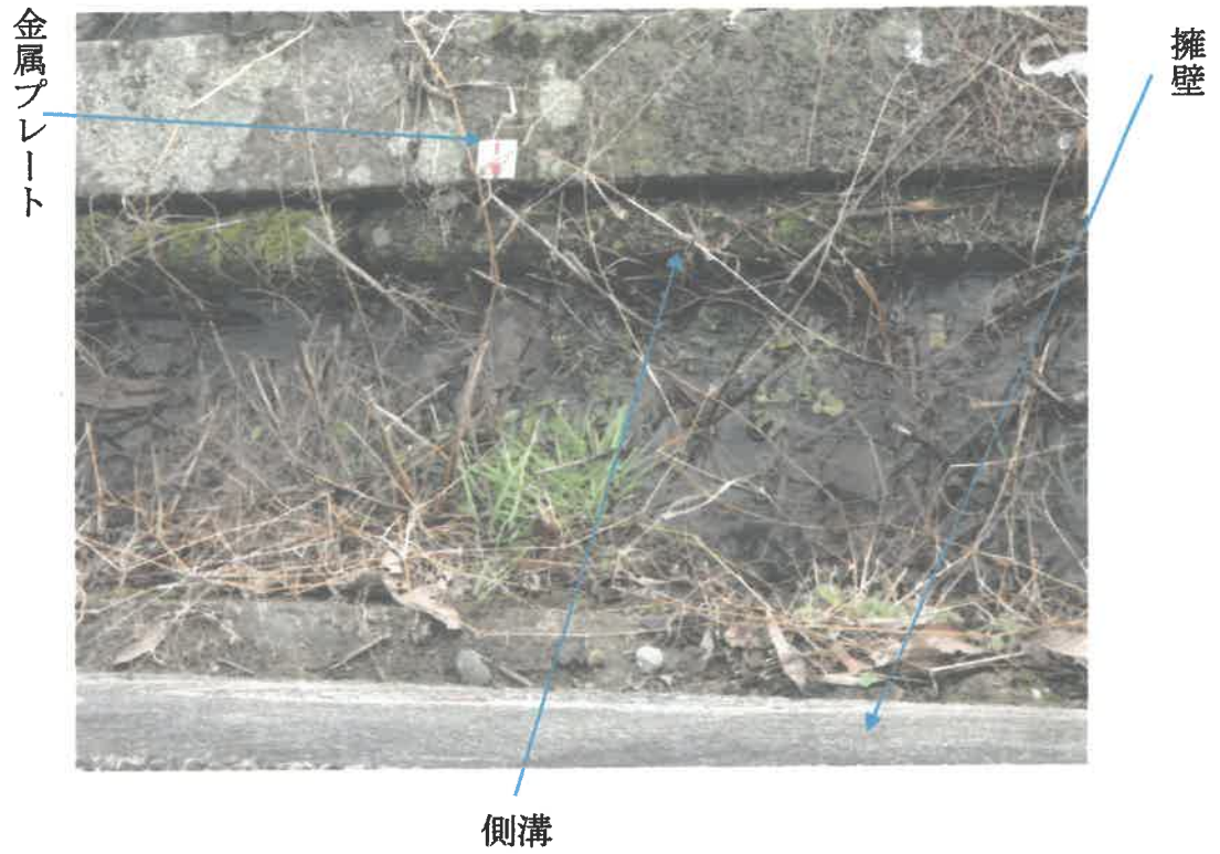
物件1 土地の南東側境界付近を撮影
