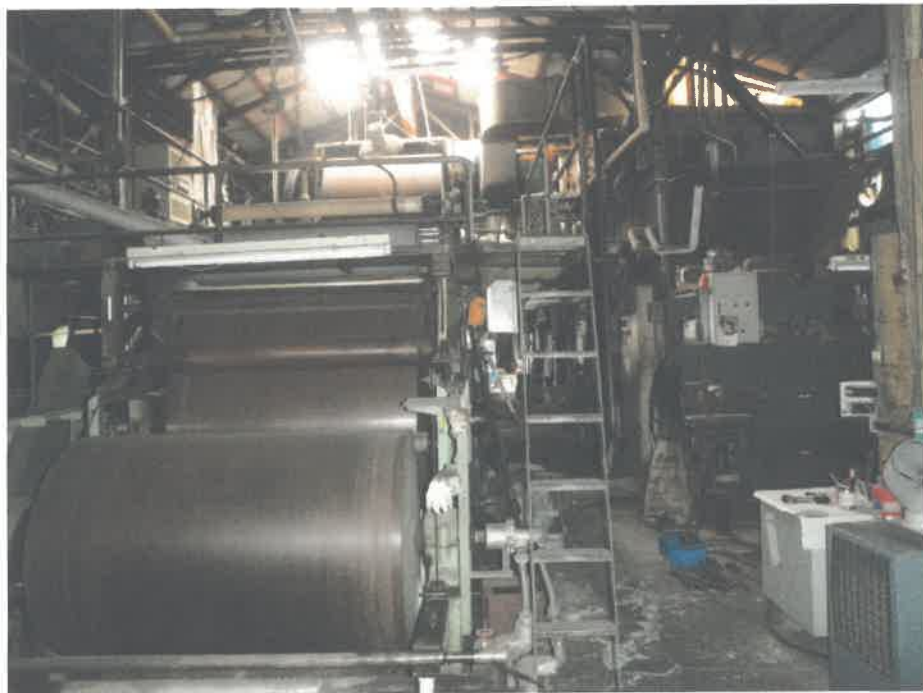
物件8建物の内部を撮影
