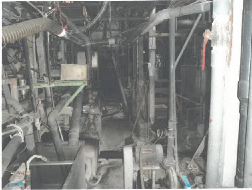
物件8建物の内部を撮影
