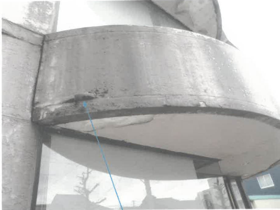
外壁の損傷
