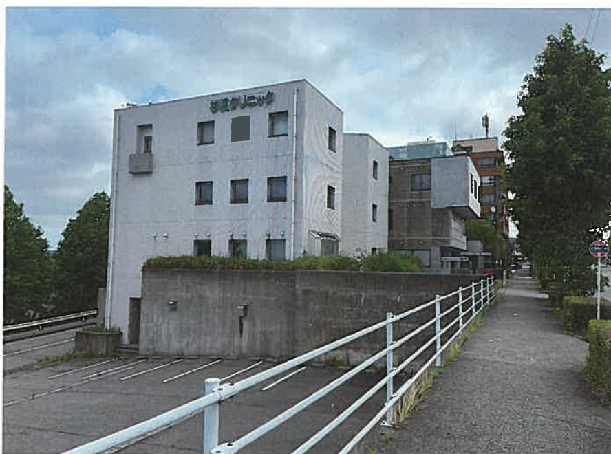
南東方より物件2・3・5を中心に
