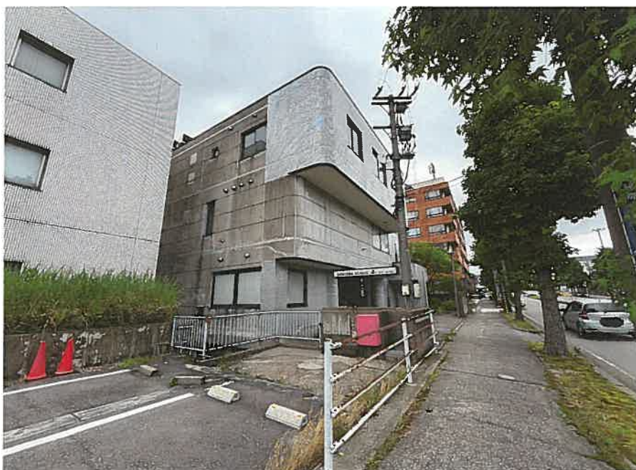
南東方より物件1・4
