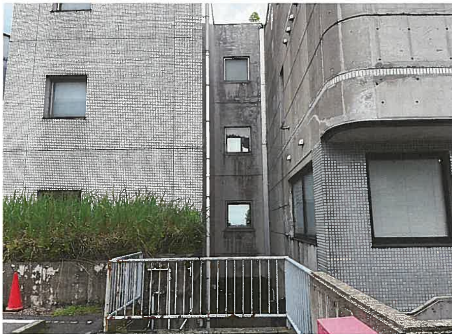
東方より物件5と4の渡り廊下
