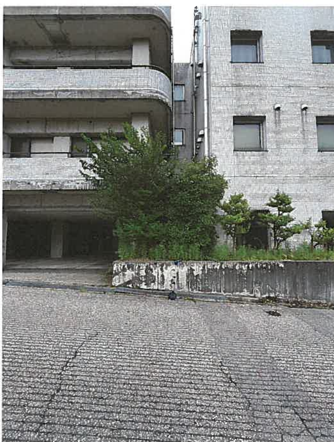
西方より物件4と5の渡り廊下
