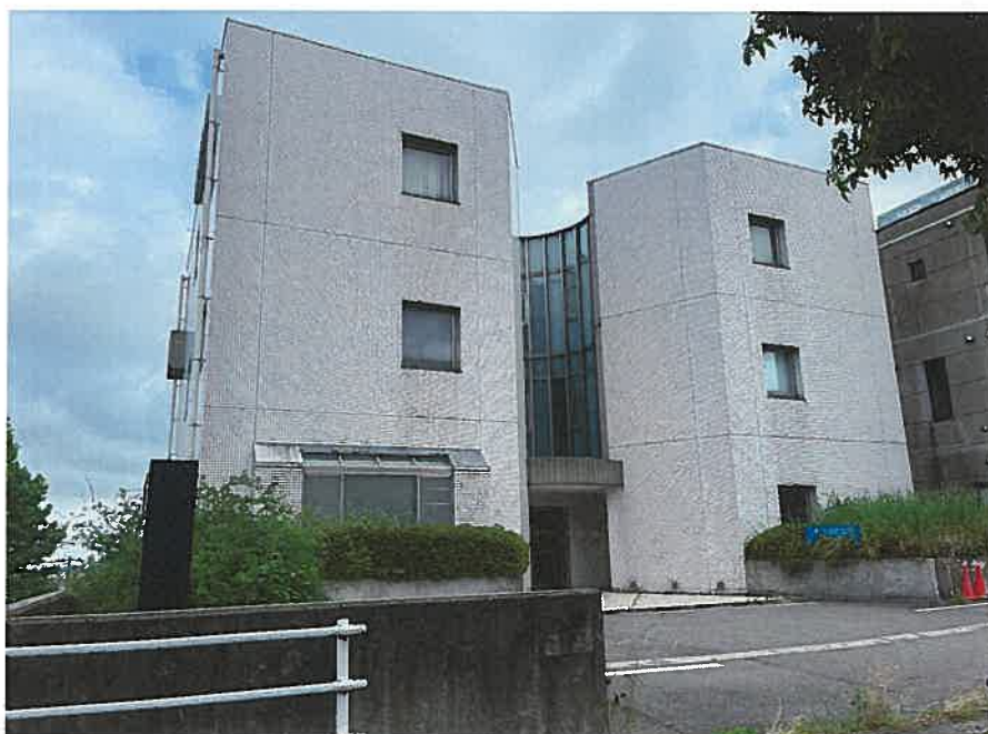
南東方より物件5
