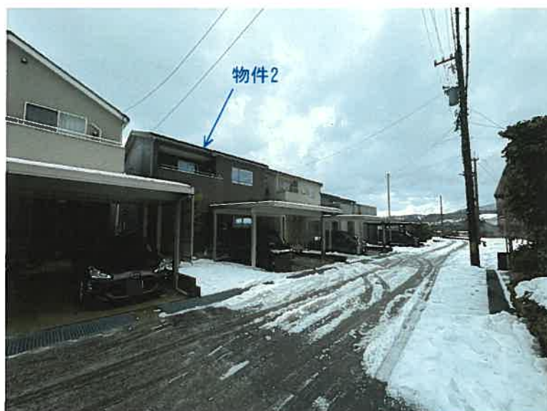
物件 1、2「南西方より撮影」
