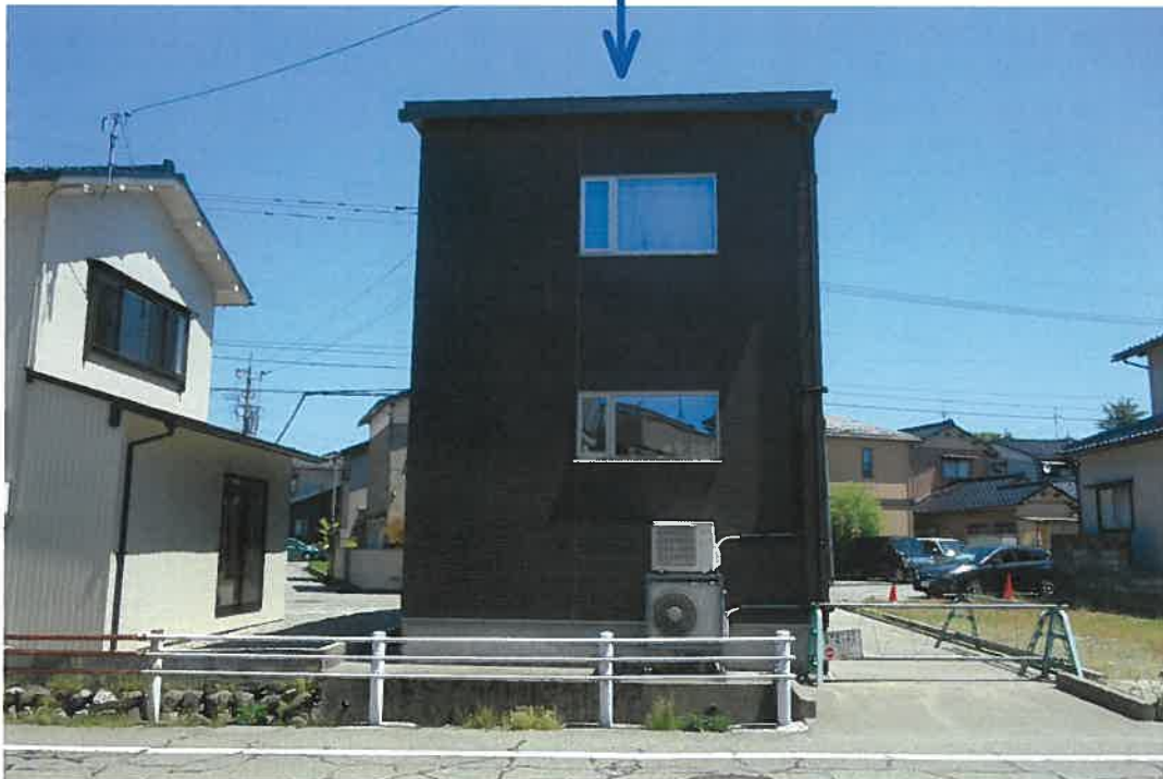
南西方向より撮影
