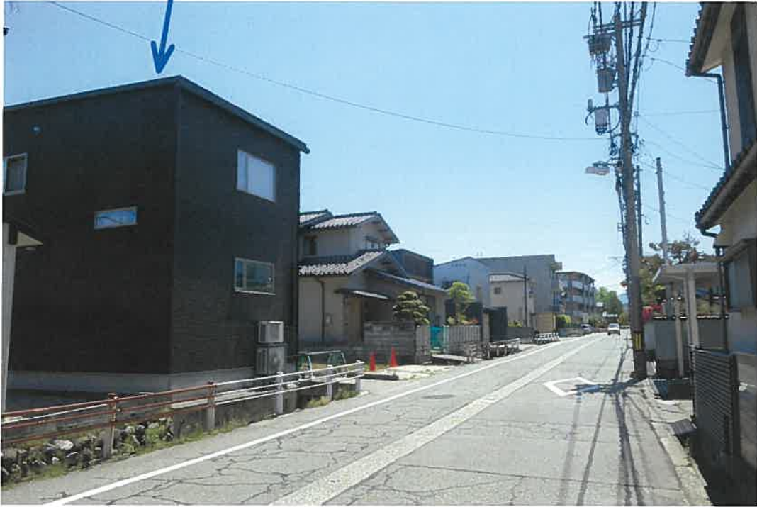
北西方向より撮影
