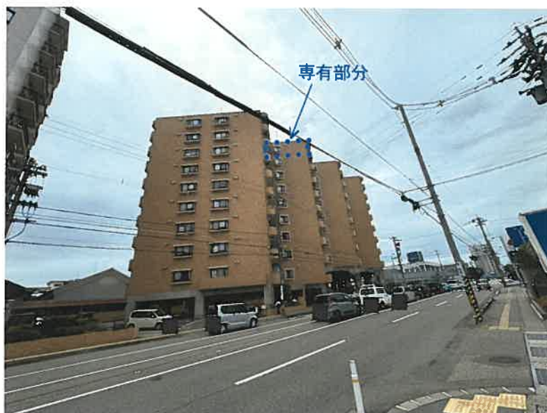
一棟の建物全体「北西方より撮影」
