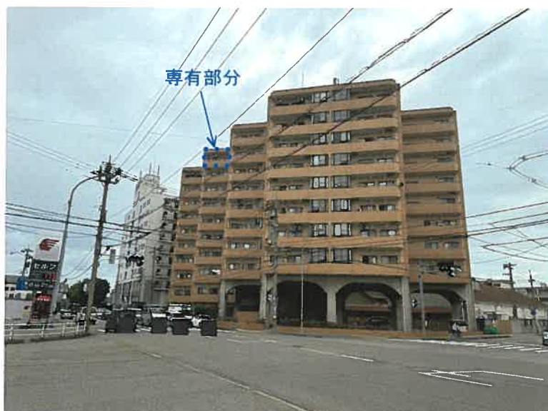
一棟の建物全体「南西方より撮影」
