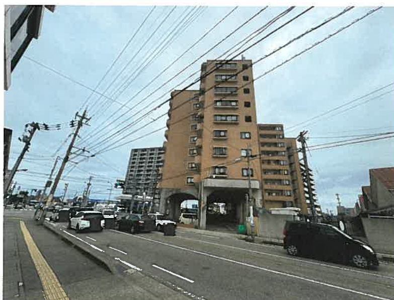
一棟の建物全体「南東方より撮影」
