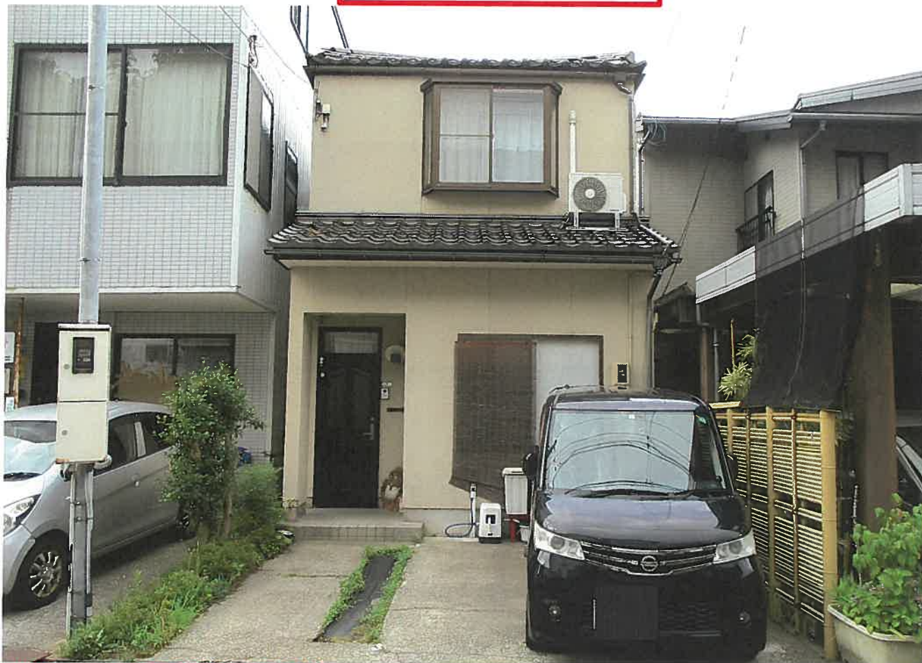
物件 1、2 をその南側から撮影
