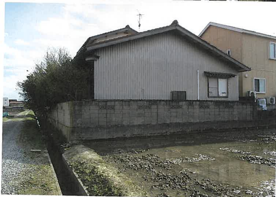
物件1～3を その北東側から 撮影
