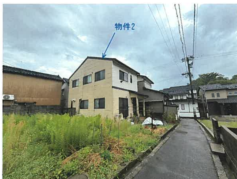
物件 1、2「北方より撮影」
