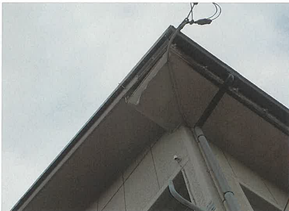
軒先の損傷状況
