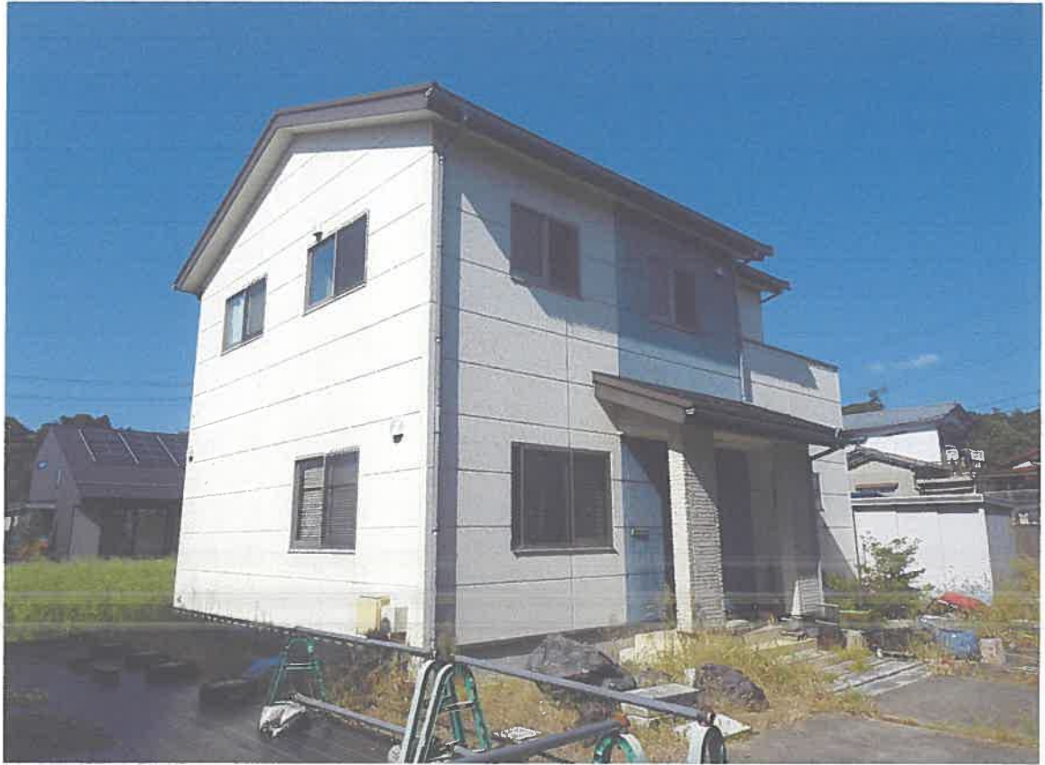
物件1、物件3(南方より撮影)
