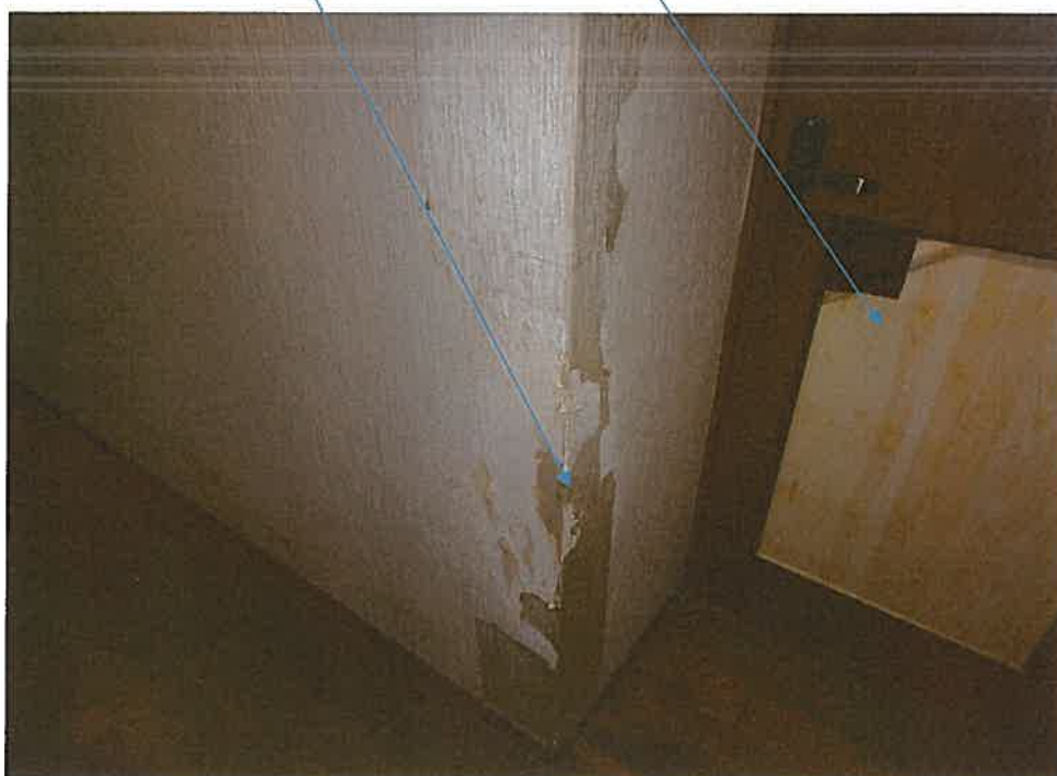
トイレのドアの損傷状況
