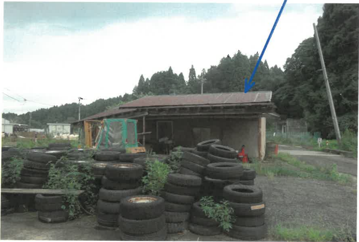
北西方向より撮影
