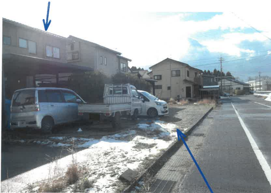
北西方向より撮影
