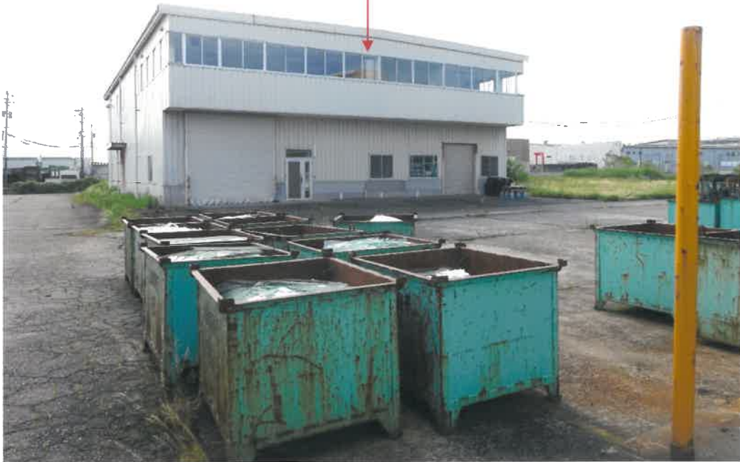
物件10の建物（主である建物）
