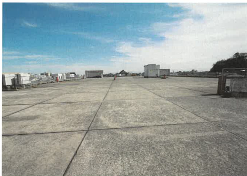
写真⑨ 屋上
