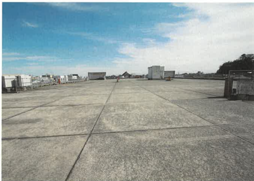
写真⑨ 屋上
