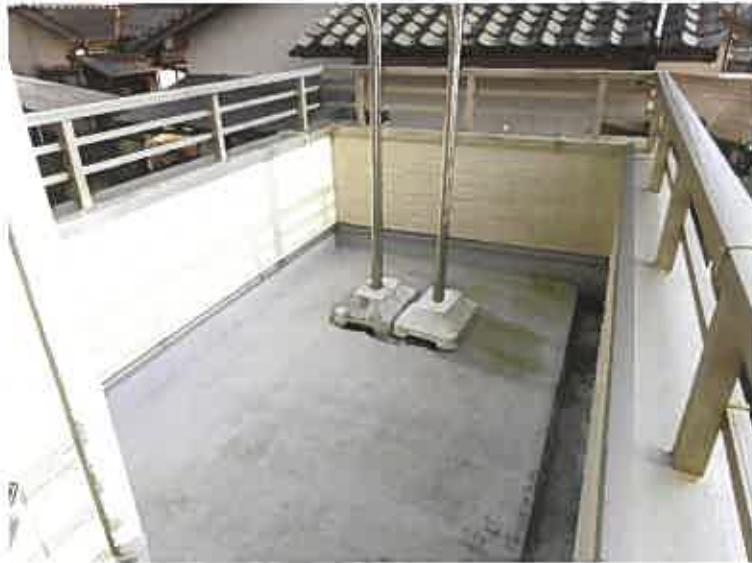
写真17 (本件建物 2階バルコニー)
