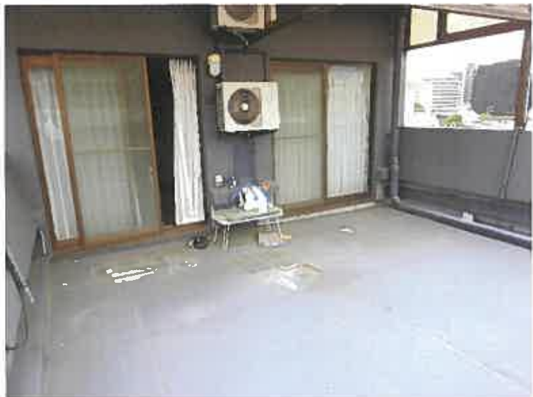
写真3 2 (物件4の建物内 (5階))
