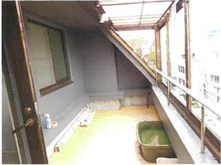
写真3 1 (物件4の建物内 (5階))
