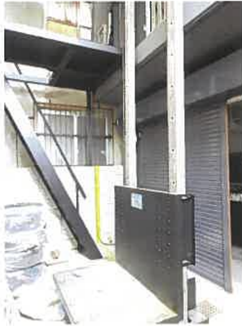
写真5（本件各建物のある一棟の建物の南側にあるリフト（1階））
