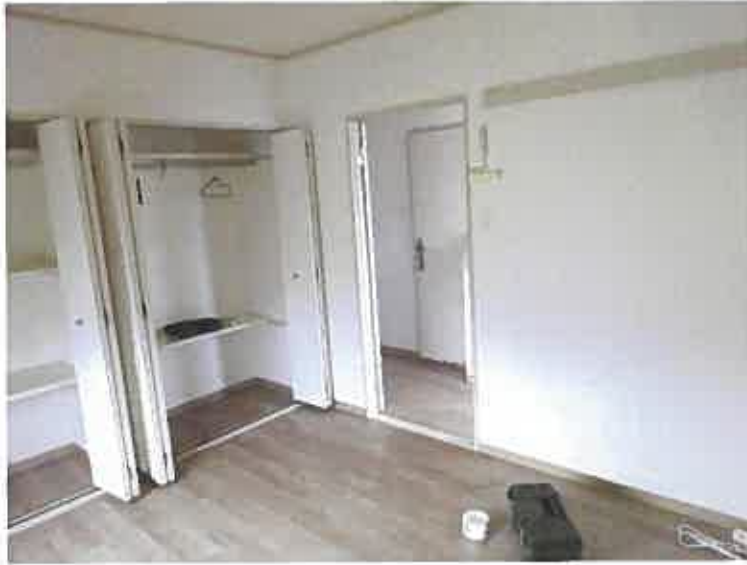
写真25 (物件4の建物内 (4階))
