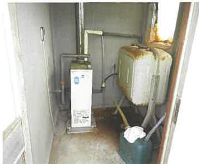
写真18 (本件建物 屋上)
