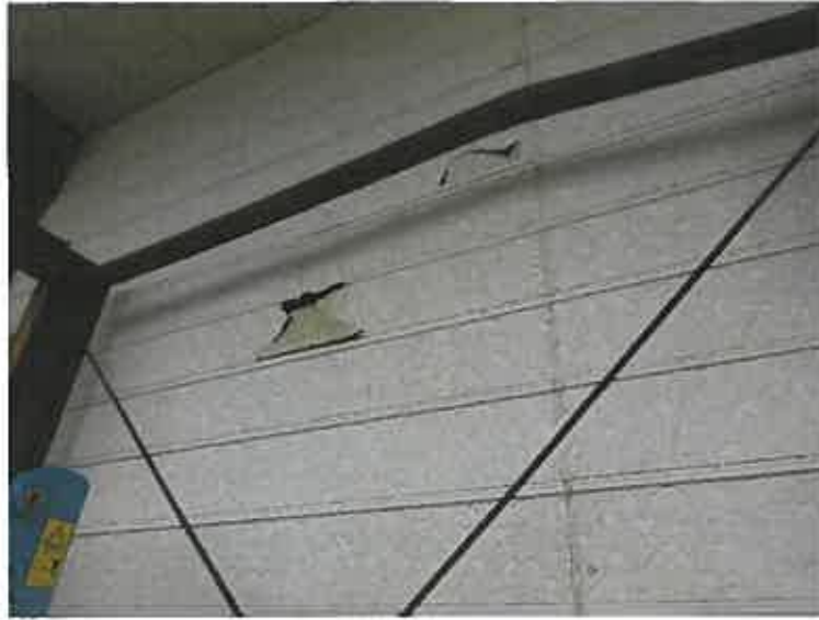
写真4 (本件建物の1階の外壁)
