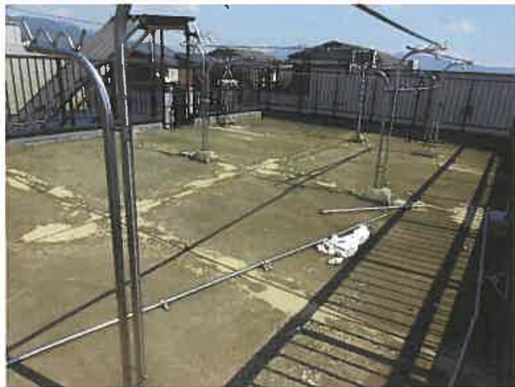
写真12 (本件建物 屋上)
