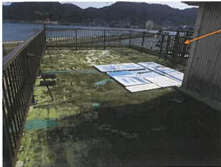
写真28 (物件2の建物 屋上)
