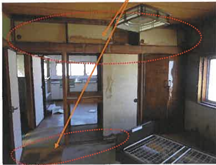
写真22 (物件2の建物 3階) 雨漏りが生じている箇所
