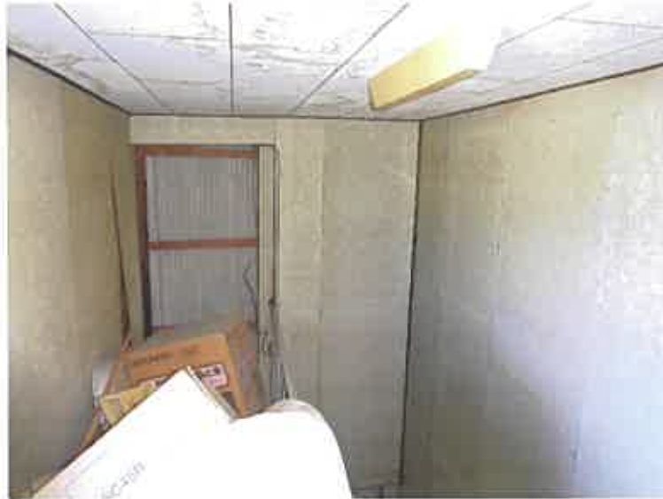
写真26 (物件2の建物 屋階)
