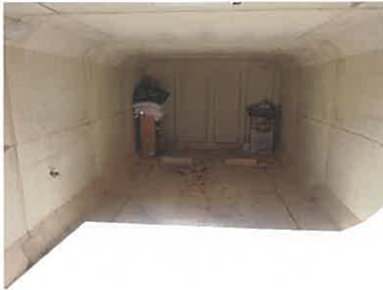
写真1 4 (未登記附属建物内)
